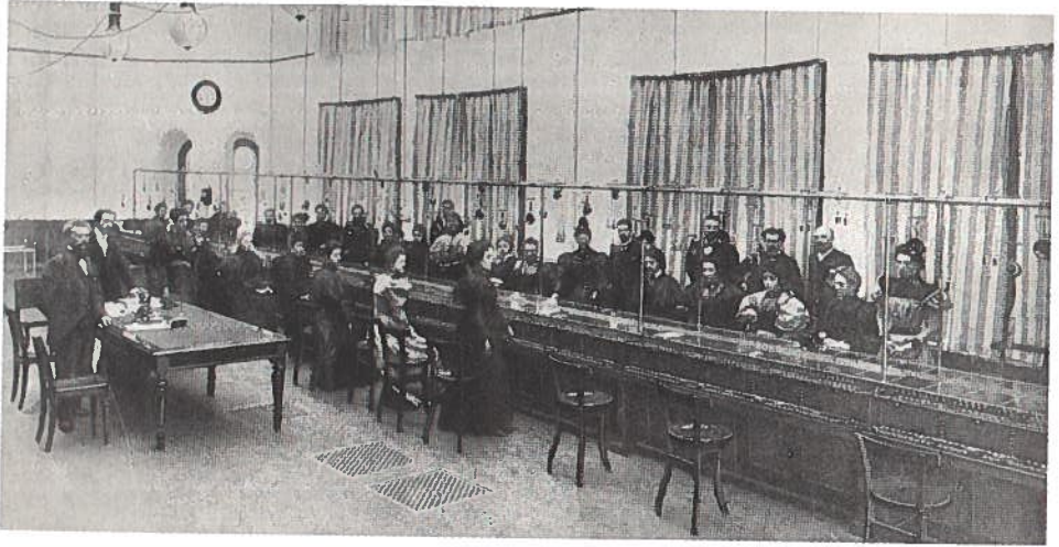
▲ Foto 6 Centrale van de Amsterdamse Telefoondienst.
